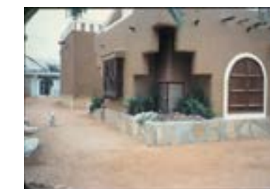
External Setting Useing Compressed Earth Block - Al-Riyadh مجلس خاص من الطين المضغوط شرق الرياض
