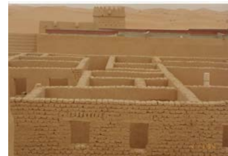
Restoration of Acient Building اعادة ترميم المباني الطينية القديمة
